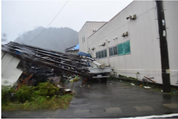
倒壊した建物
